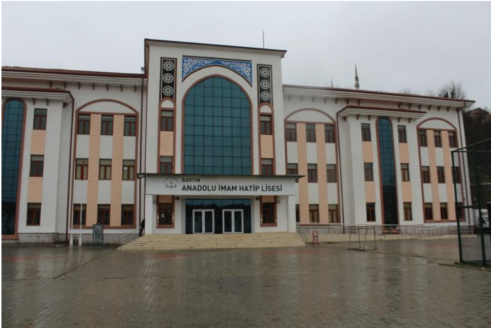
Şekil 3. Bartın Anadolu İmam Hatip Lisesi Binası
